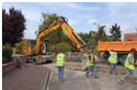
Travaux à Benfeld
